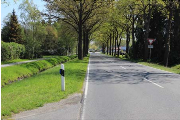
Bild 2: Jeddelloher Damm → Osten
