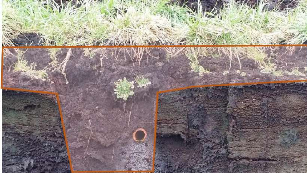
Abbildung 2: Bodenprofil mit landwirtschaftlichem Oberboden und Drainingraben (braun hinterlegt)
