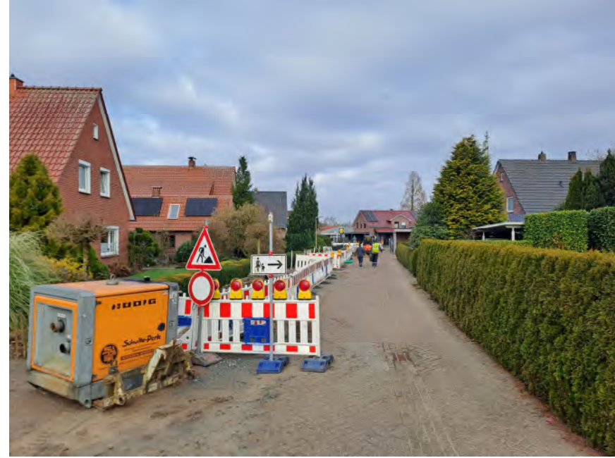
Sanierung RW Süderesch, III. BA
