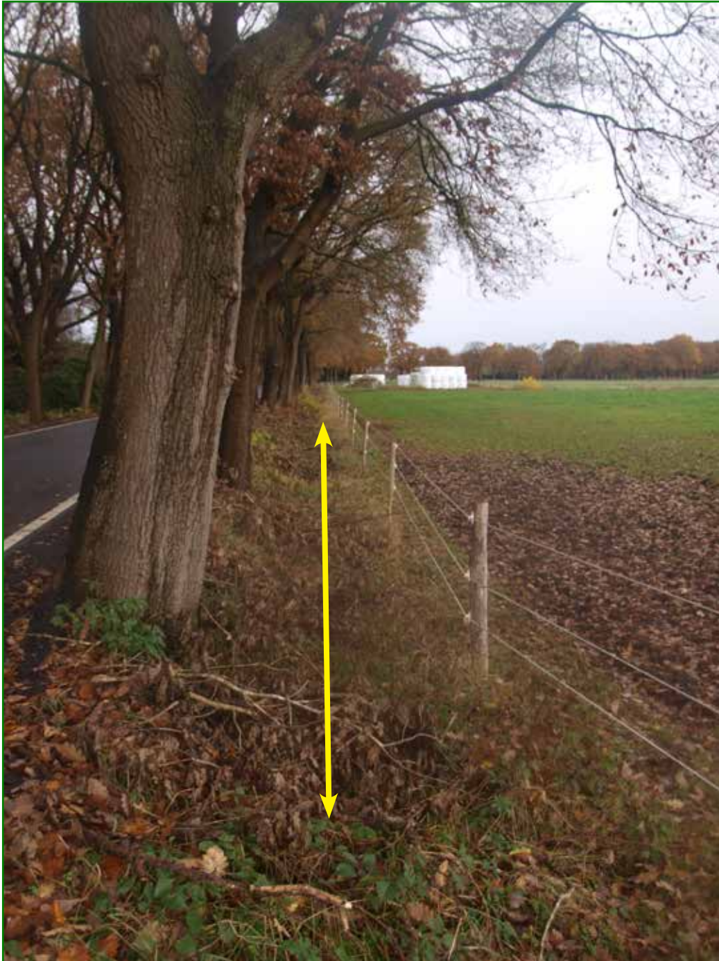
Abb. 3: Im südlichen Abschnitt dieses Bereiches ist der Graben noch vorhanden. Er verläuft zwischen dem Weidezaun und den Wurzelhälsen der dort stehenden Eichen. Es kann davon ausgegangen werden, dass dieser Graben eine Sperre für das Wurzelwachstum darstellt. Die Wurzel der Eichen stabilisieren das Bankett der Fahrbahn und verlaufen eher parallel zur Fahrbahn. Der wasserführende Graben wird eher nicht durchwurzelt.
