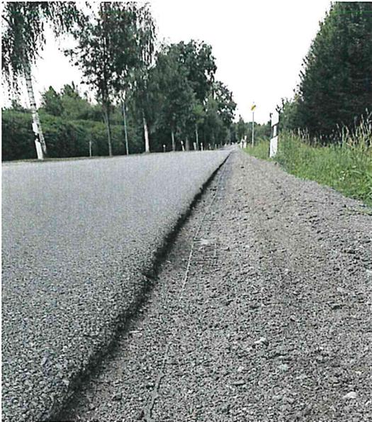
Abbildung 2: Auswaschung Fahrbahnkante
