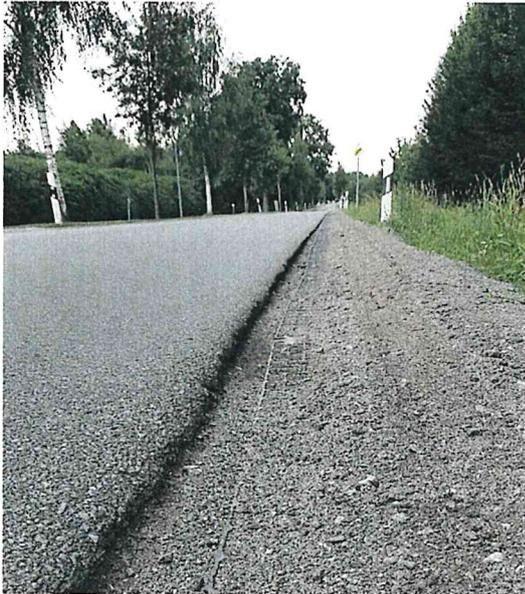
Abbildung 2: Auswaschung Fahrbahnkante
