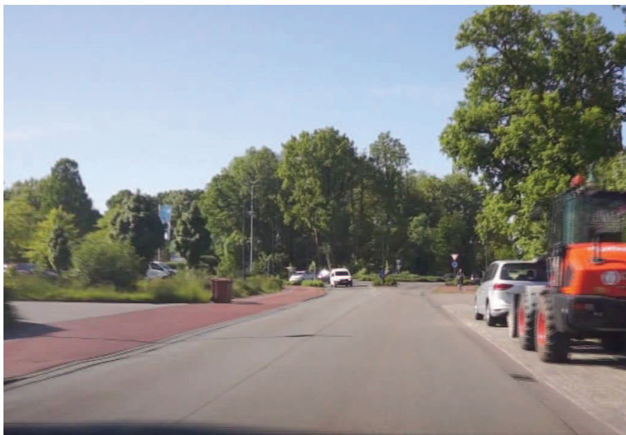
L 831 Blickrichtung Süd auf den Kreisverkehr. Links Anbindung EZH-Nutzung, rechts hinter den parkenden Kfz vorhandene Einmündung Weg.
