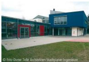
Erweiterung eines Gymnasiums um einen autarken Gebäudeteil mit 10 Klassen, Cafeteria, Pausenhalle, Sanitäräume. Mauerwerksbau; Stb-Filigrandach, Holzpultdachkonstruktion.
